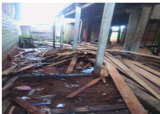
Figura 12. Resíduo madeireiro depositado aos arredores de um estabelecimentos, próximo a residências no município de Laranjal do Jari-AP.
