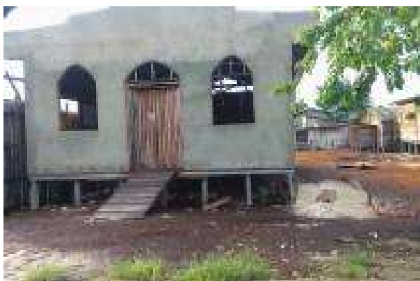
Figura 13. Aterramento realizado com resíduos madeireiros no município de Laranjal do Jari-AP.
