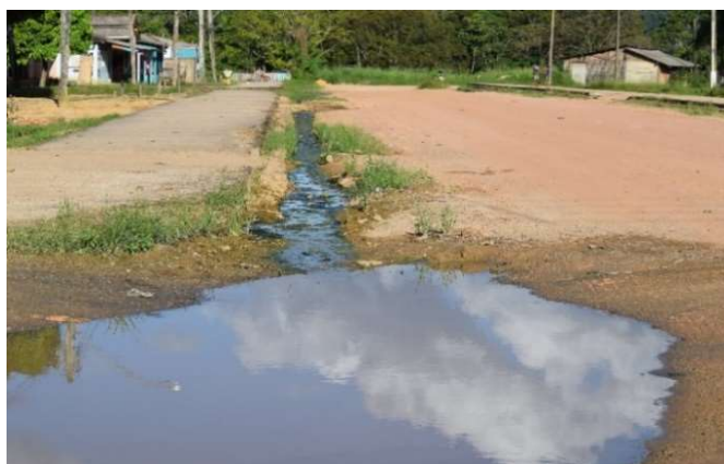
Figura 20: Poça de esgoto acumulado entre Rua Rio Jari e Rua Ipiranga
