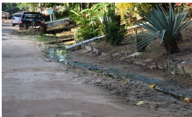
Figura 18: Esgoto lançado direto na Rua Cultura
