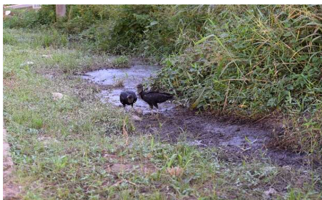
Figura 21: Urubus em vala de esgoto na Rua Alvorada
